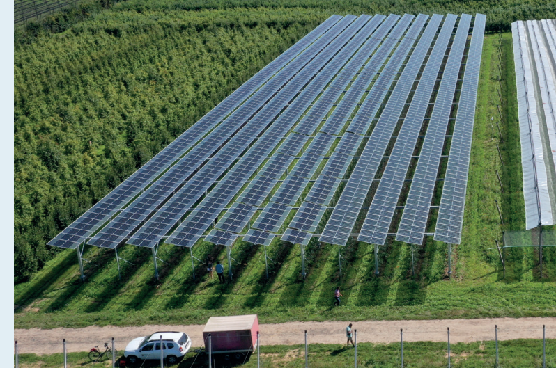
Apfelplantage mit Agri-PV-Anlage in Gelsdorf, Deutschland mit 258 kW p installierter Leistung.
